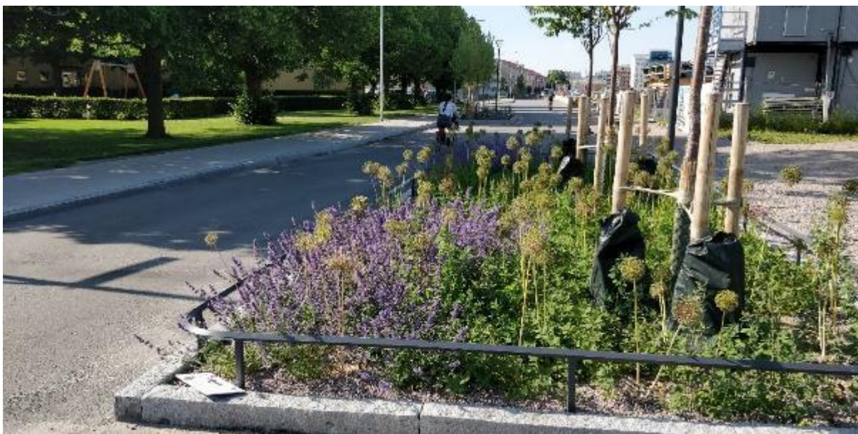
Figur 25. Biofilter Östra Sala backe i Uppsala.
