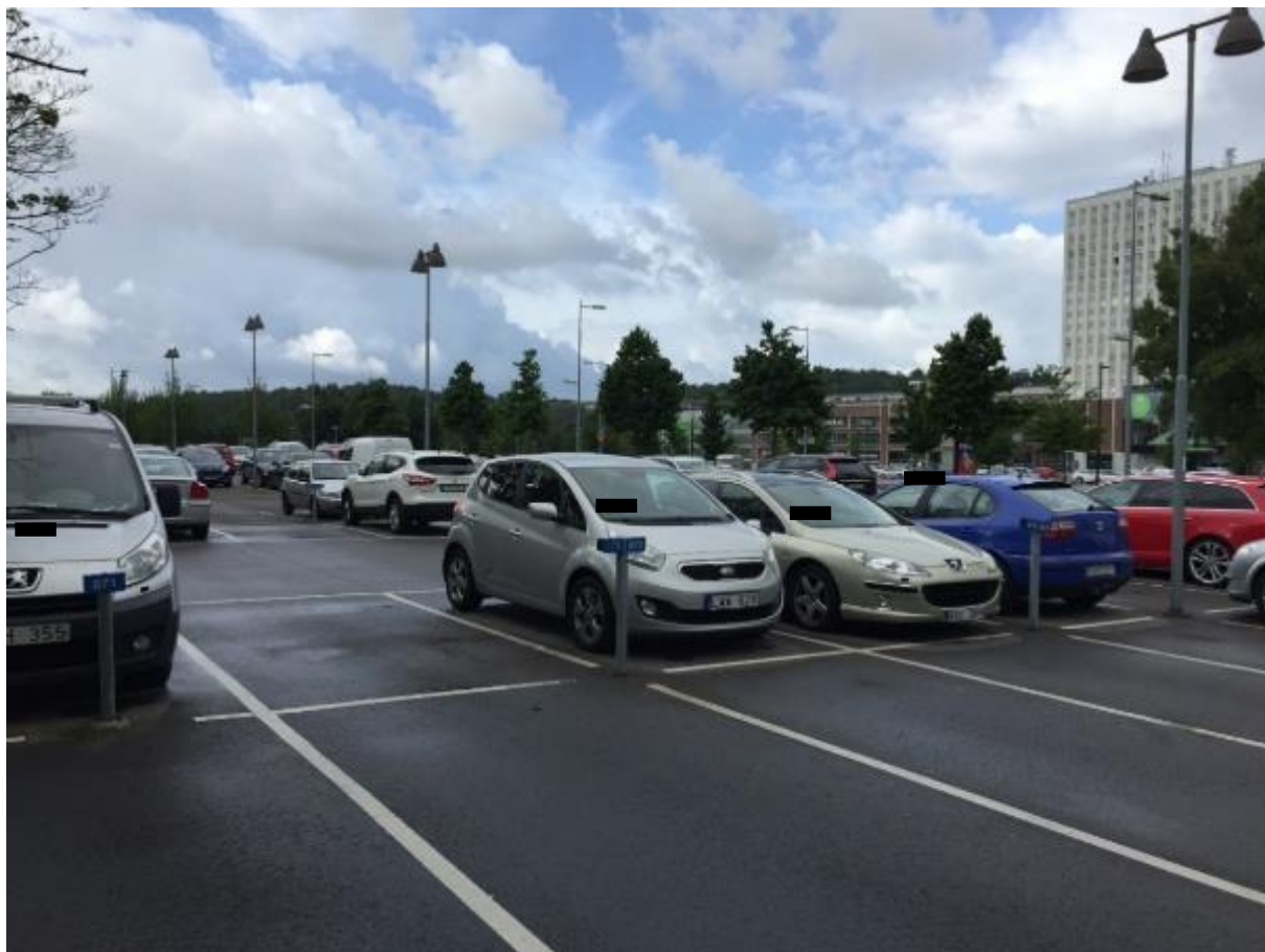
Figur 5. Detaljplaneområdet är huvudsakligen hårdgjort med stora parkeringsytor.
